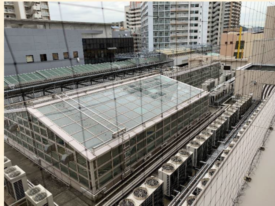
図 2-4 吹き抜けガラス
